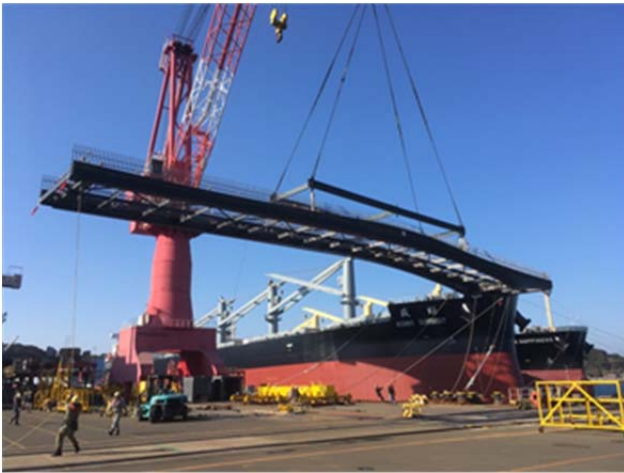
【当社工場で製作された出島表門橋】
