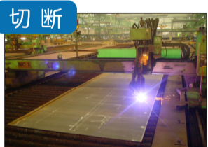
設計情報に基づいてロボットが自動的に鋼板を切ってゆきます。
