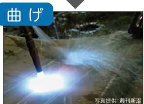
鋼板を曲げて、流線型の曲面を造りだします。
