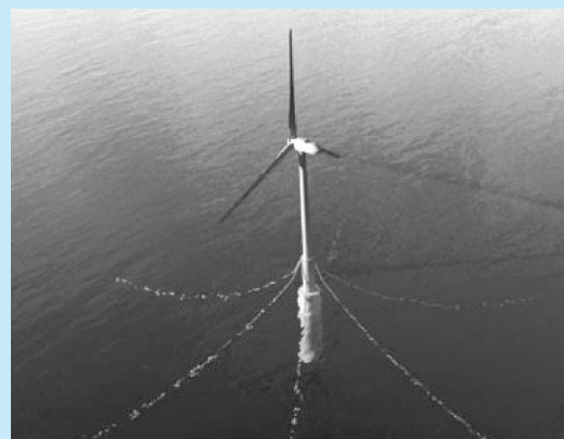
浮体式洋上風力発電プラットフォーム (写真提供: FOWT開発チーム(京都大学、海上技術安全研究所、佐世保重工業(株)、戸田建設(株)、富士重工業(株)、新日鉄エンジニアリング(株)他) (FOWT=FLOATING OFFSHORE WIND TURBINE))
