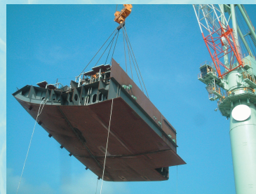
ブロックを大型クレーンで吊り上げて搭載
